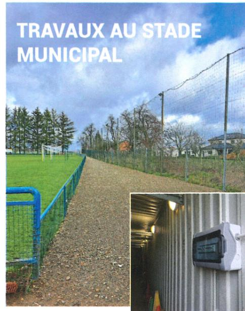
Afin d'alimenter en électricité les deux bungalows de stockage de matériel du stade municipal situés sur le terrain no 2 et le local buvette de la tribune du même terrain, il a fallu tirer **une ligne souterraine** à partir des vestiaires du terrain no 1.
