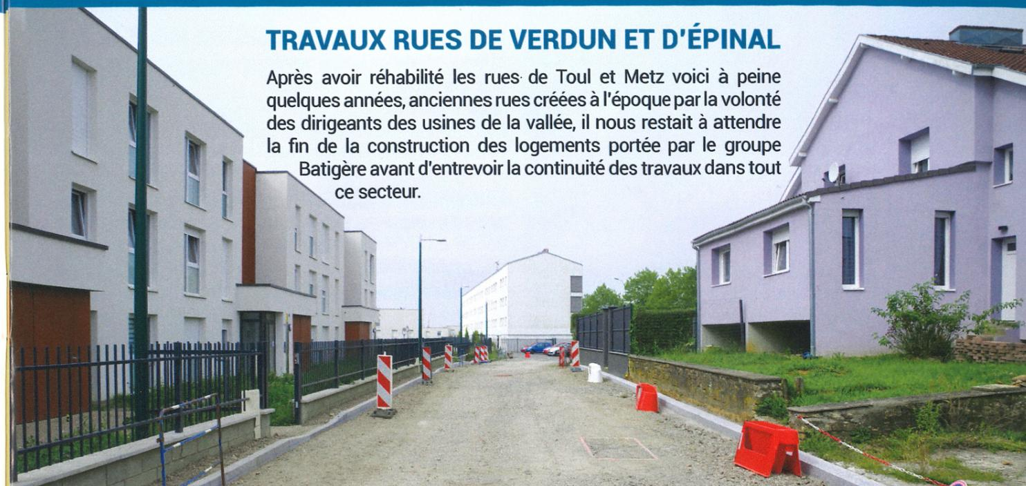
C'est ainsi qu'un premier linéaire de la rue de Verdun et la rue d'Épinal vient maintenant de se voir rajeuni par l'enfouissement total des réseaux, la pose d'un tout nouvel éclairage économique et le remplacement des bordures béton par de belles bordures en granit. Une nouvelle couche d'enrobés est venue terminer le tout. Ne restent plus que quelques petits travaux de marquage et autres, à finir mais déjà, c'est sûr, l'œil est tout autre dans ce secteur.
